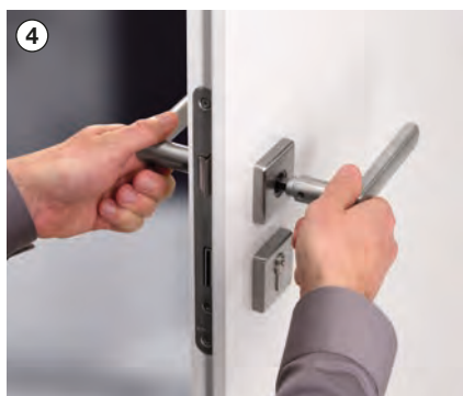
4 Griffe zusammenstecken und Innensechskant-Schraube festziehen
