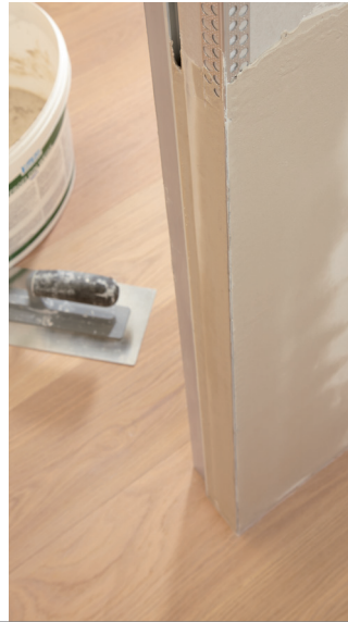
04 VERSPACHTELN MIT FASERVERSTÄRKTER SPACHELMASSE
