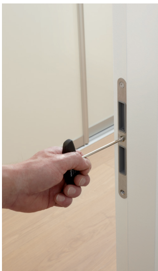
06 MONTAGE DES SCHLIESSBLE- CHES FÜR DAS MAGNETFAL- Lenschloss
