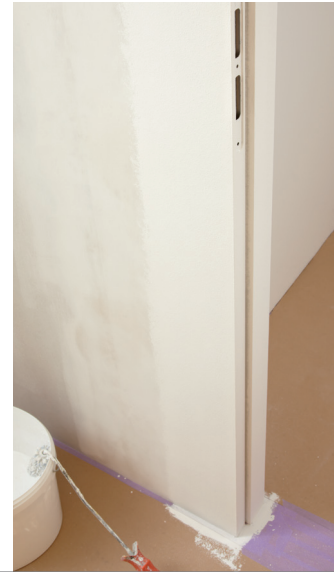
05 ANSTREICHEN DER WAND UND DER GRUNDIERTEN ZARGE
