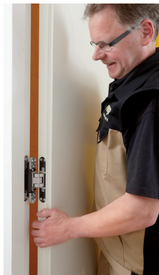
07 EINHÄNGEN DER TÜR. DIE 3D-BÄNDER SIND BEREITS IN DER TÜR MONTIERT.
