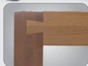
Schwalbenschwanzverzinkung in Hinterzange und Beiladerücken
